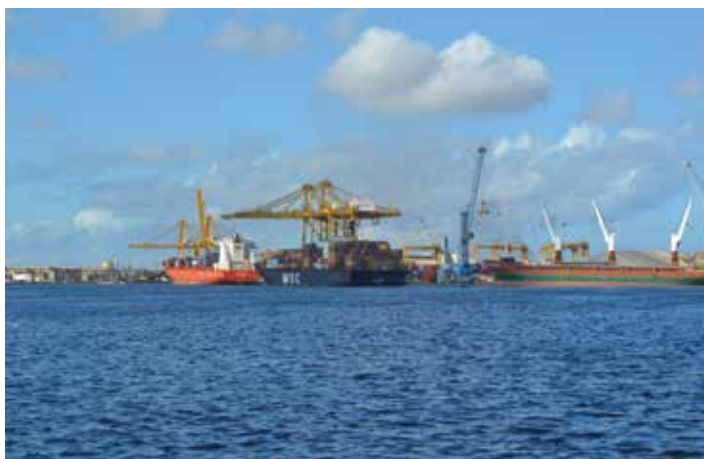
Portiques au PAD
