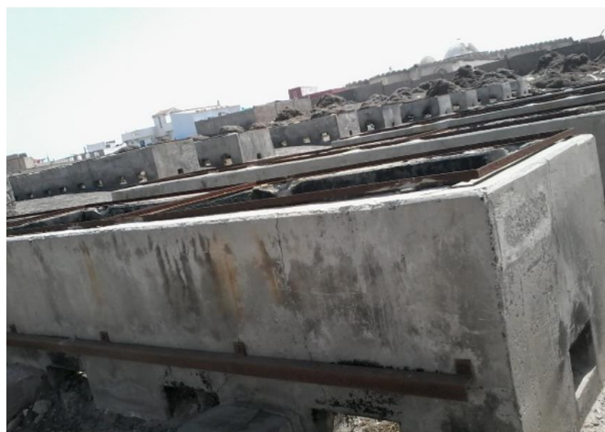
Figure 14. Modèle de four parpaing en béton armé vibré (source : Camara S, 2022)
